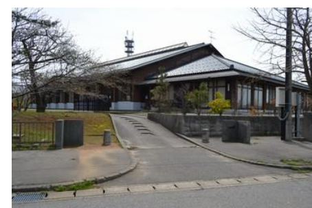
亀代 (H7建設)
