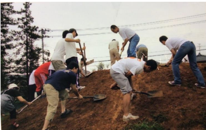
平成19年7月 保護者による築山修復工事
