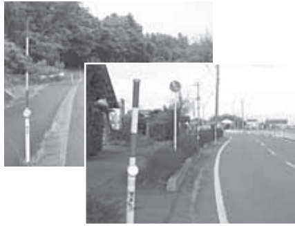
▲スノーポールの設置状況
