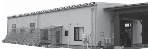
生ごみたい肥化施設
