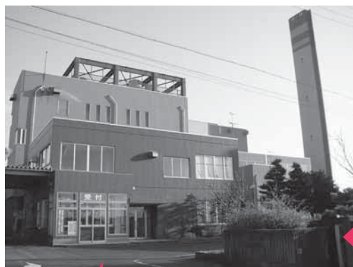
豊栄環境センター (ごみ処理施設)
