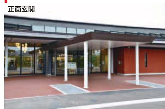
東側にあり、飯豊連峰からの朝日を正面に受けます。庇を大きくすることで明るさを抑え、開放感がありながらも落ち着いた雰囲気を演出しています。
