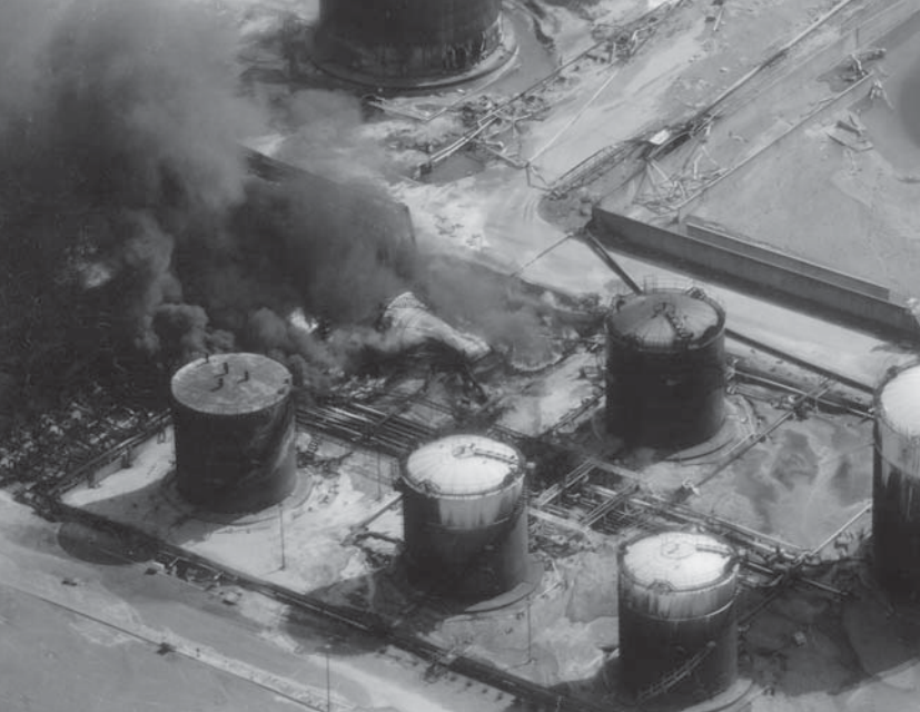
地震で発生した火災によりガソリンタンクは全く原型を留めない姿となりました。
