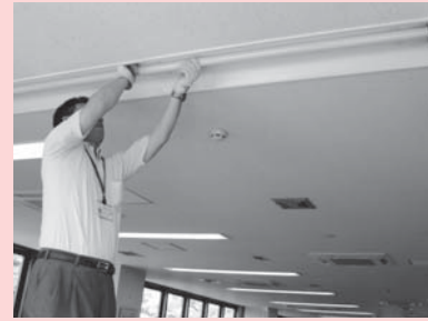
蛍光灯の間引き作業
