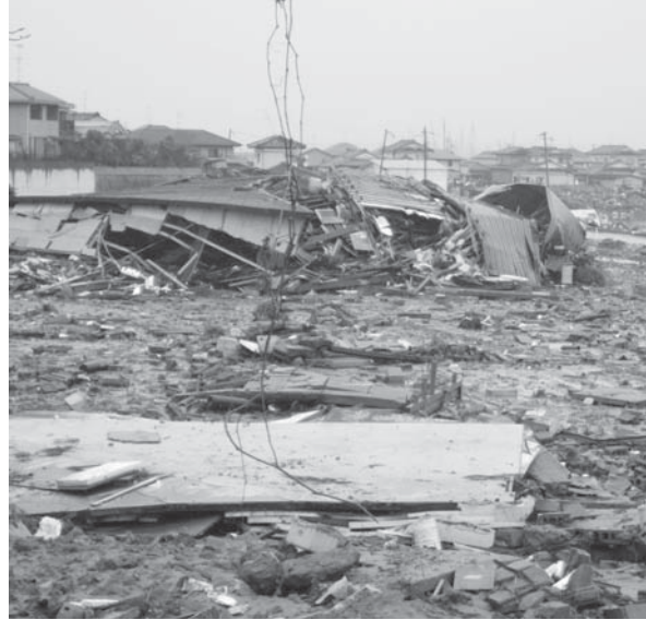
七ヶ浜町の被害状況 (3月15日 災害派遣職員による撮影)
