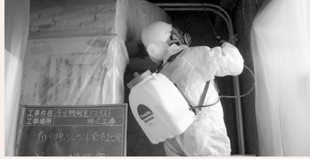
▲アスベストの除去作業
