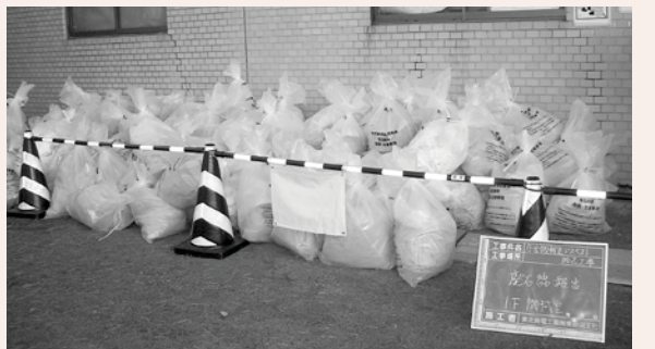
▲二重袋に密封され搬出されたアスベスト
