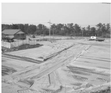
▲順調に進む造成工事
