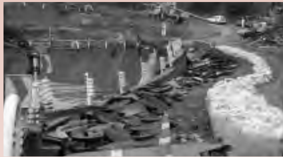
被害を受けた道路
