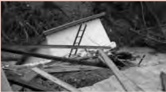
倒壊した家屋
