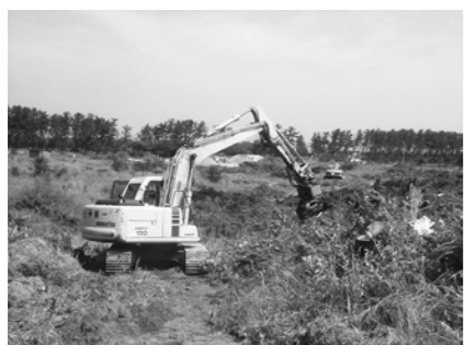
▲造成工事(伐採、伐根作業)
