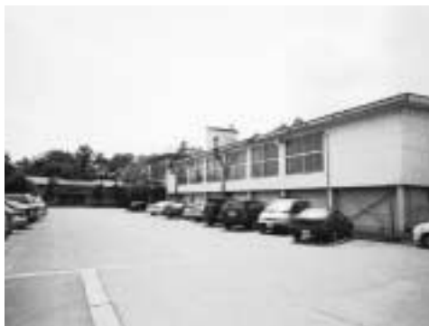
研修会館を車庫に改修するため現在、検討が行われている。
