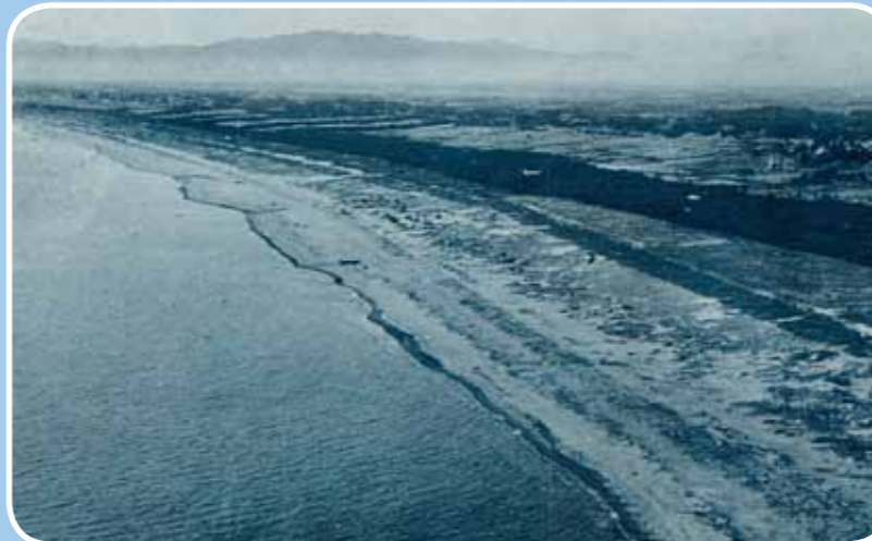
昭和39年当時の掘り込み地点付近
