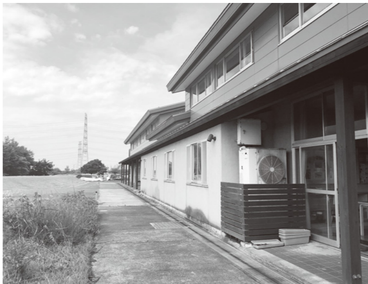
▲室外機は傷みが早い
