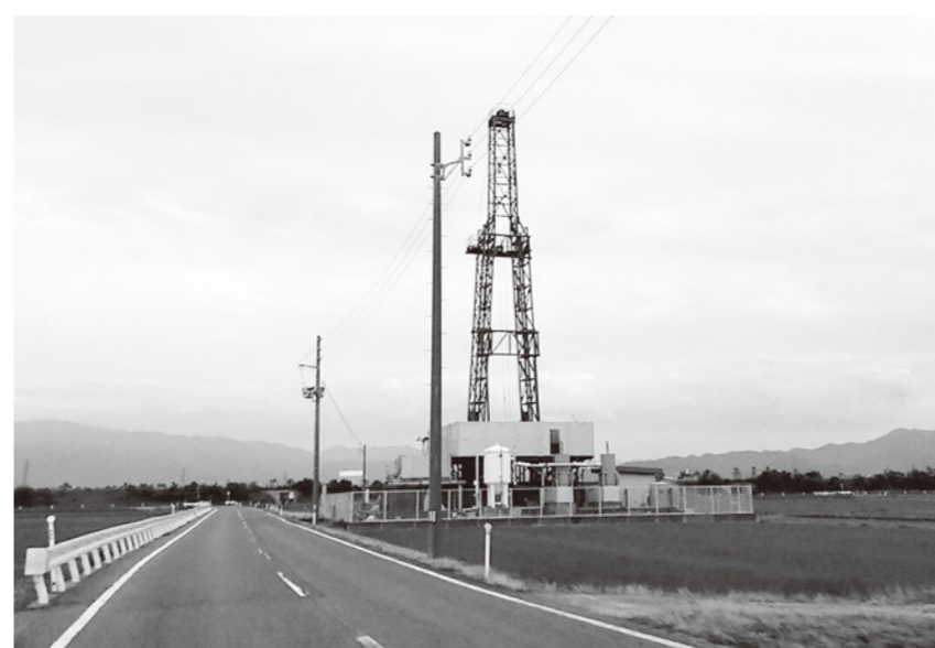
▲掘削工事に高いタワーが出現
