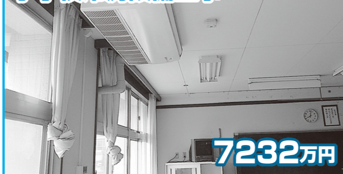
小学校冷房設備工事
