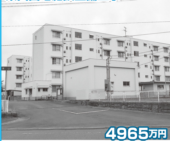
東山団地施設整備工事
