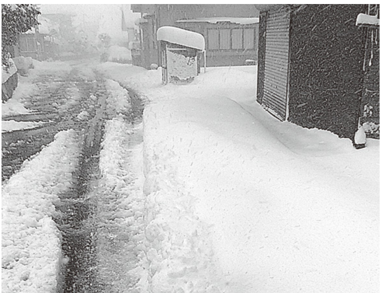
▲機能してほしい消雪パイプ
