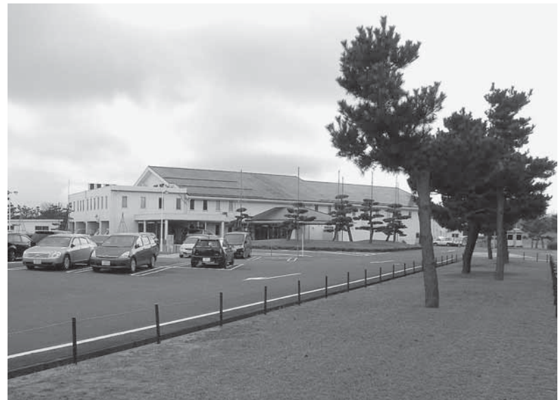
▲広大な面積を有している東港のゴルフ場
