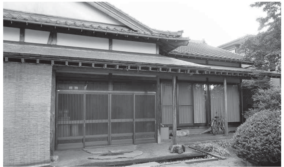
▲ 耐震改修待たれる住宅
