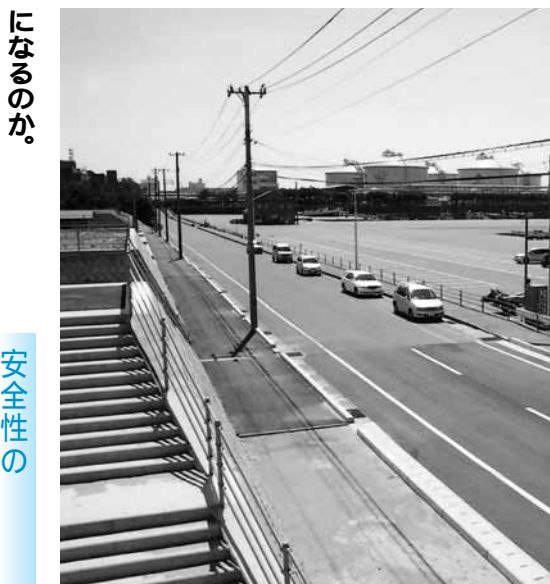
にぎわいが期待される海洋交流施設整備
