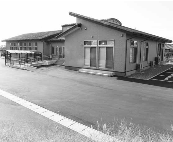
外構工事も完了した亀代地区公民館
