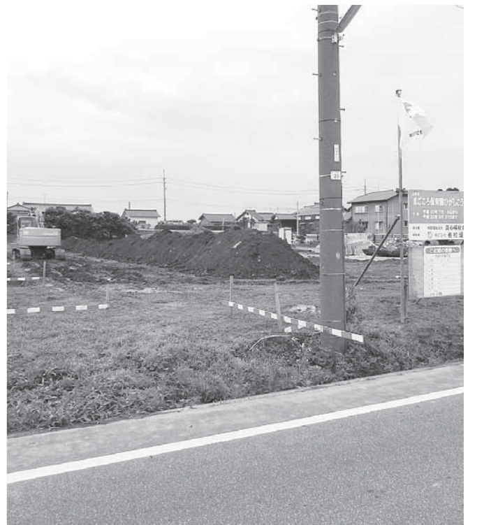
工事が進む私立保育園
