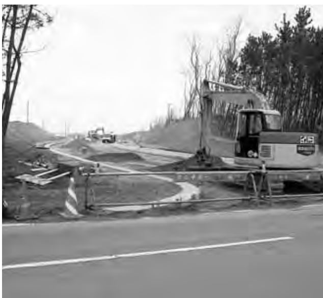
▲着々と工事が進む網代浜緑地整備
