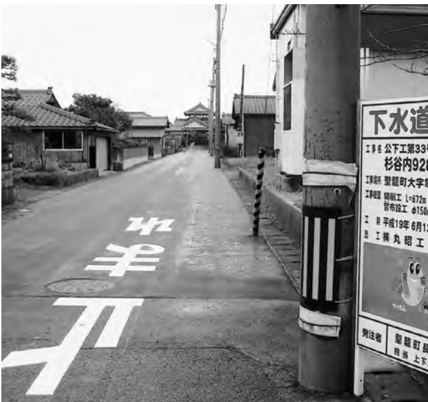
▲整備が終わった下水道工事（杉谷内地区）
