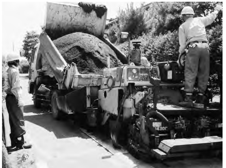
作業が進む舗装工事
