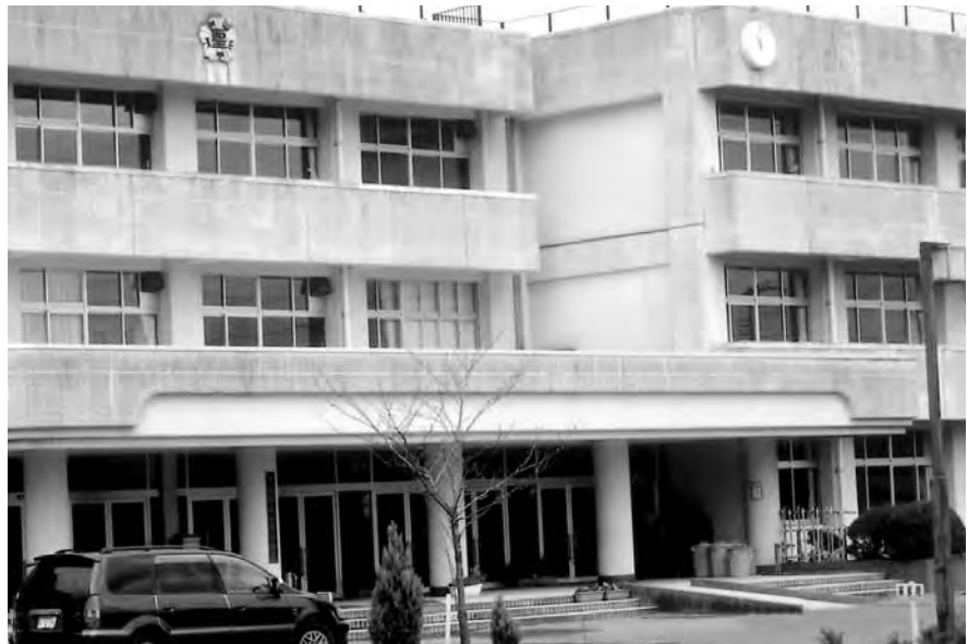
▲耐震補強が待たれる山倉小学校
