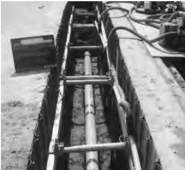
▲整備が進む公共下水道
