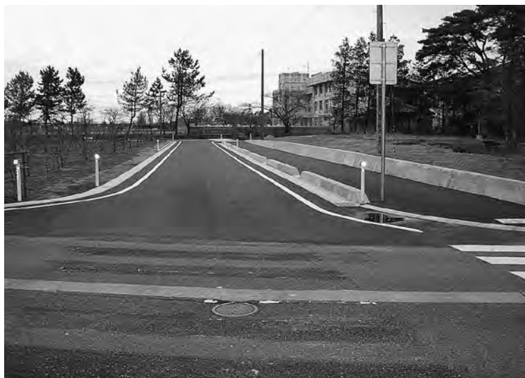
▲ 山倉小学校グラウンド入口道路
