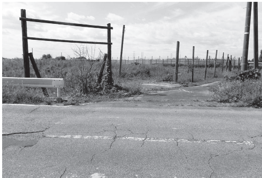
▲協議中の加治川公園付近
