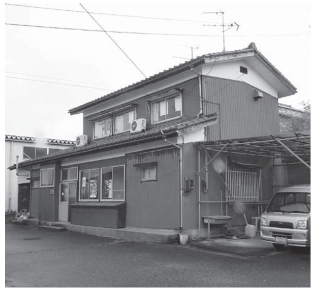
▲間もなく新築予定の聖籠土地改良区事務所
