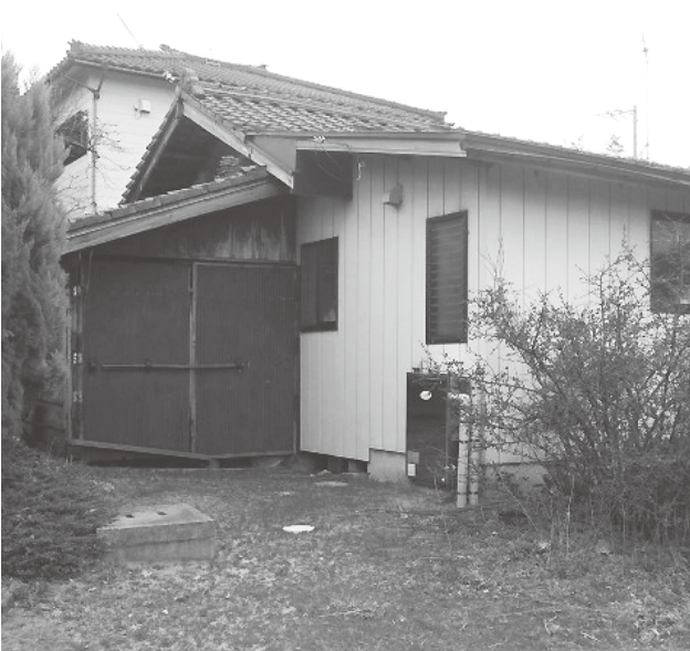
▲空き家となって約20年
