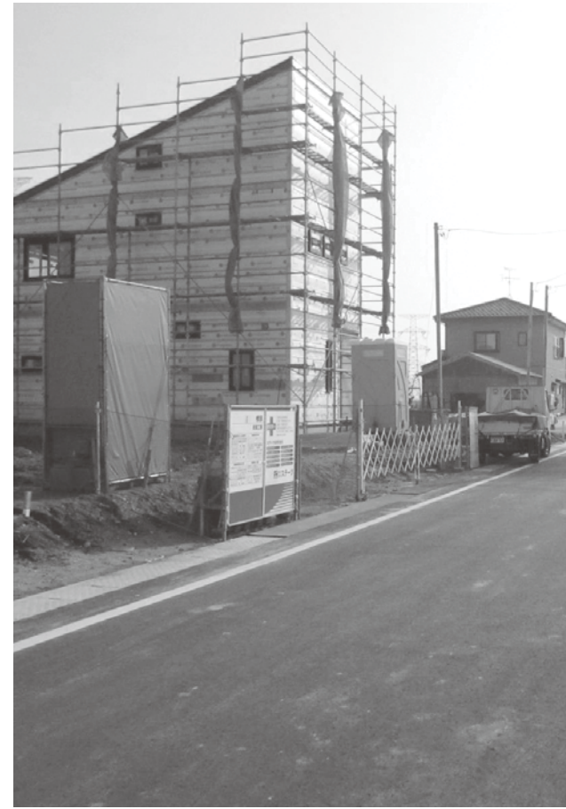
▲建設が進むざぶ〜ん館前宅地造成
