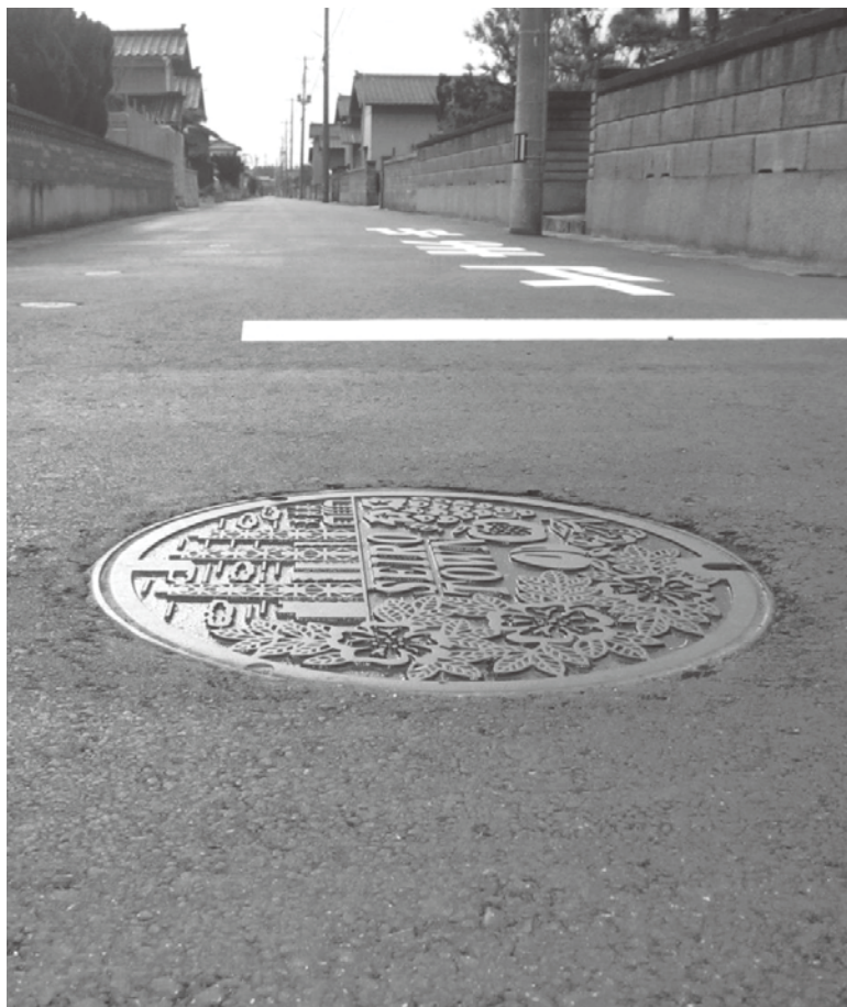
▲亀塚地区の上水道工事完了
