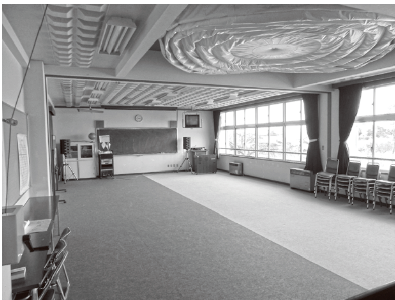
▲改修予定の教室
