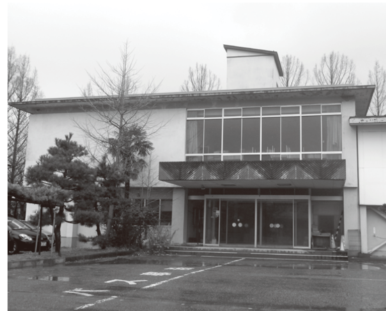
▲改築が待たれる防災倉庫
