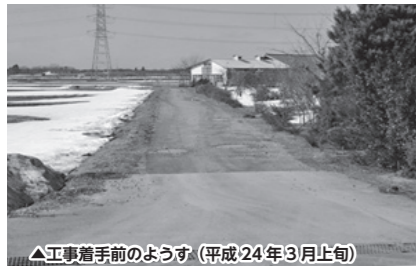
△工事着手前のようす(平成24年3月上旬)
