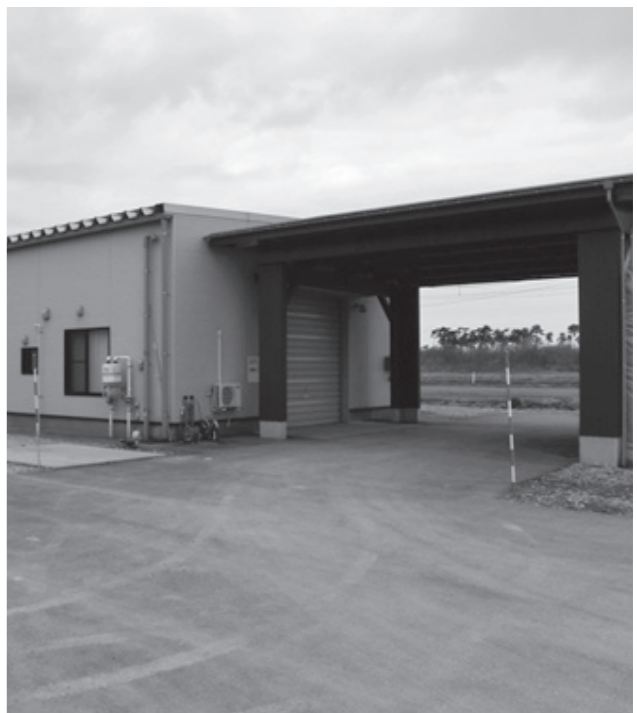
▲いよいよ販売開始 生ごみ堆肥センター
