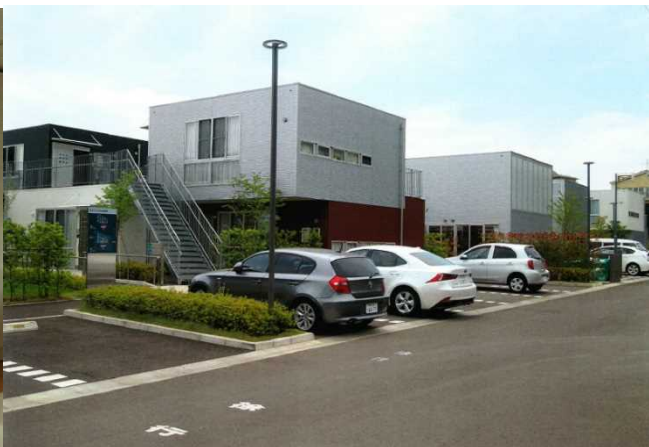
▲駐車場側外観
