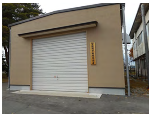
中央防災倉庫
