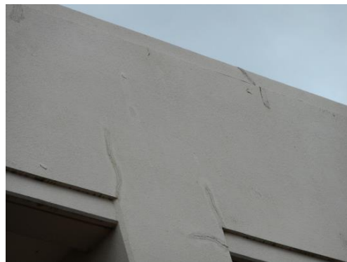
■ 柱・梁部の構造クラック補修箇所
