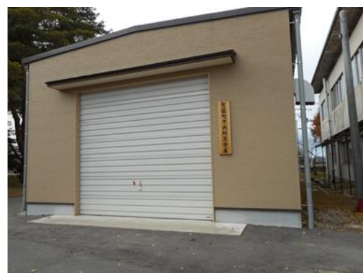
中央防災倉庫
