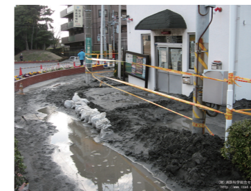
東日本大震災での液状化被害 (一財)消防防災科学センター
