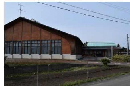
山倉 (H11建設)
