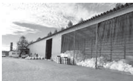
▲プラスチック処理施設の様子
