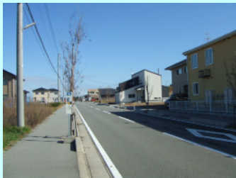
土地区画整理事業地内道路
